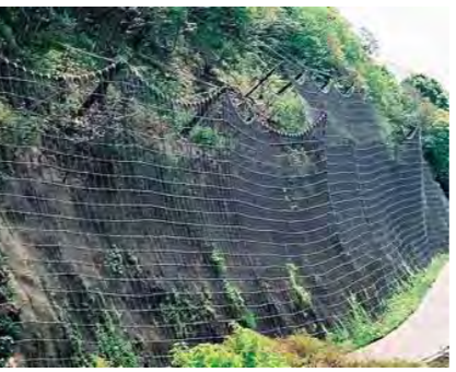
既存の落石防護網カーテンネットの技術を応用
